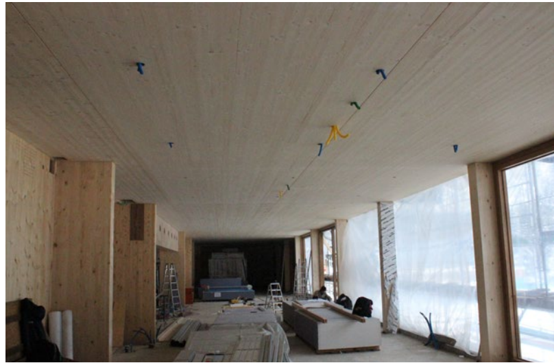
Sopra, la soletta sopra il pian terreno in XLAM nella sala ristorante, sospesa alle pareti sovrastanti e con finitura a vista.
