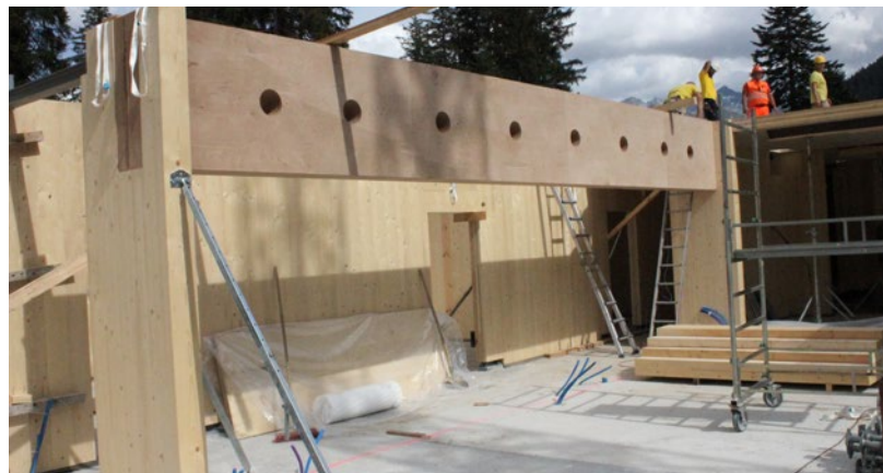
Sotto, trave ad alta resistenza in microlamellare di faggio (eazione 300 x 1020 mm, lunghezza 9,40 m).
