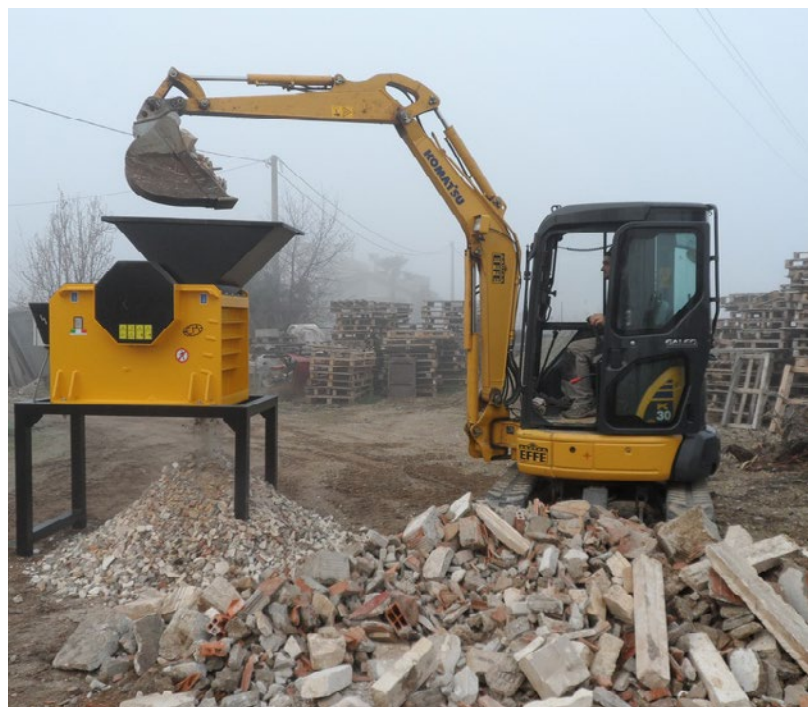
Un frantoio mobile per il riciclaggio di materiali da demolizioni.
