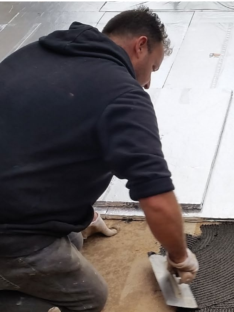
Isolazioni speciali con pannelli sottovuoto incollati.
