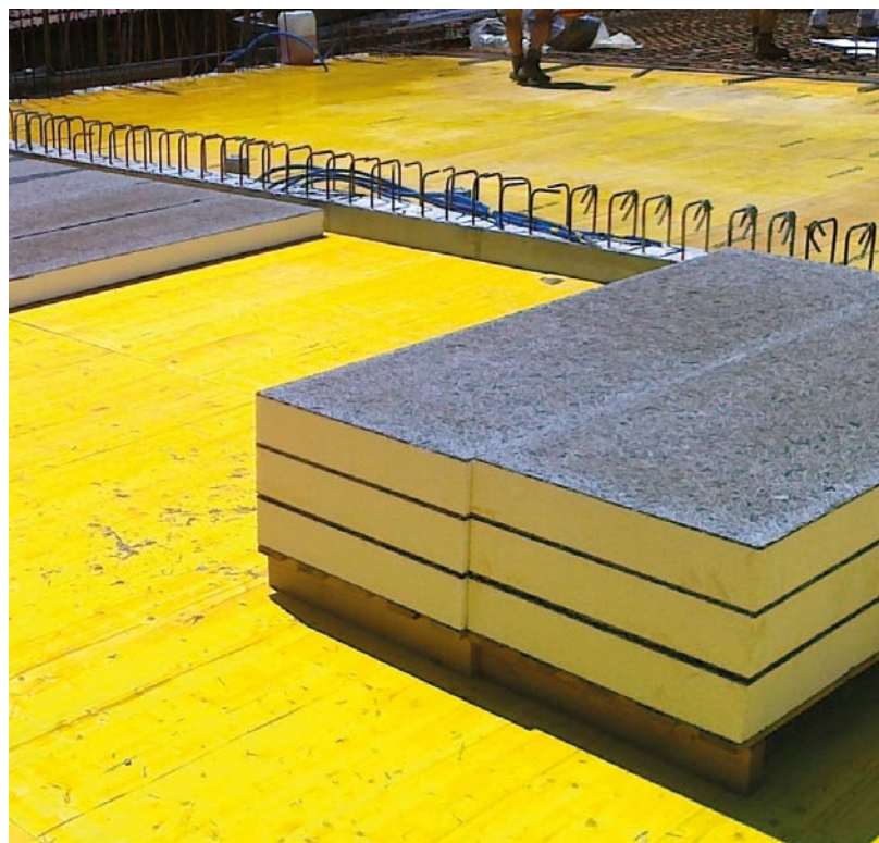
Isolamento termico sottosoletta posato in getto.
